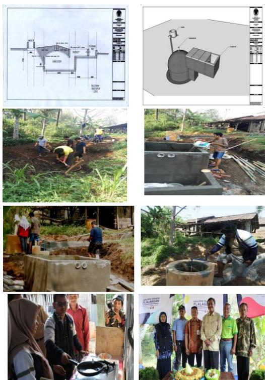
Gambar 1. Foto kegiatan gambar desain, pembangunan instalasi biogas, pengisian digester, uji coba kompor biogas dan peresmian instalasi biogas
